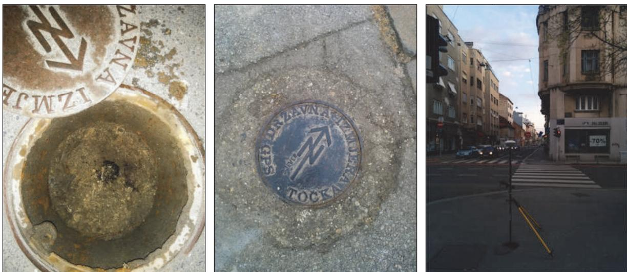
Slika 3: a) Asfalt u šahtu trajno stabilizirane GPS točke, točka stabilizirana bolcnom nedostupna b) Trajno stabilizirana GPS točka u Savskoj ulici nedostupna iz sigurnosnih mjera, c) Zaklonjenost horizonta GPS točke mreže grada Zagreba u središtu Zagreba.
