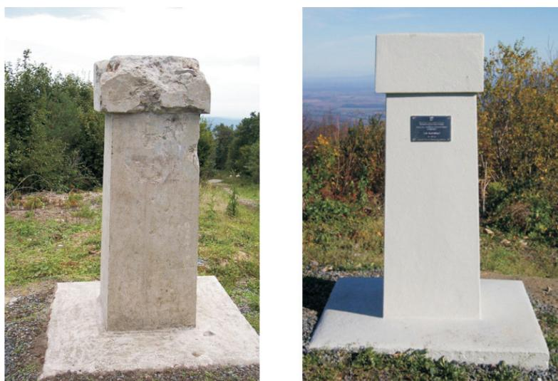
**Slika 4:** Primjer obnove trigonometrijske točke I. reda Kapavac
